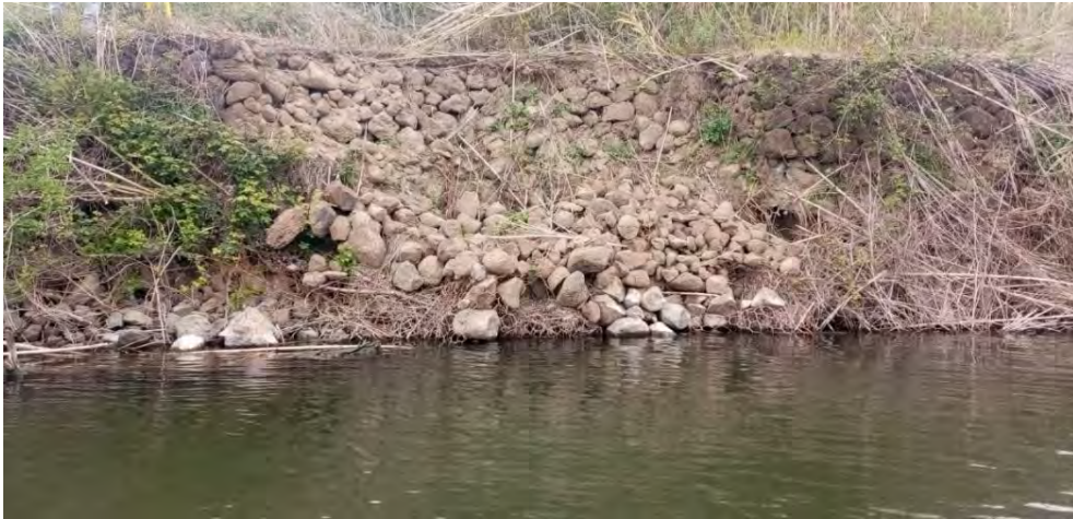
Figura 17 – Dettaglio crollo gabbionate
