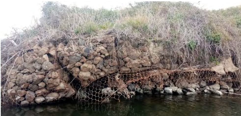
Figura 17 – Dettaglio crollo gabbionate
